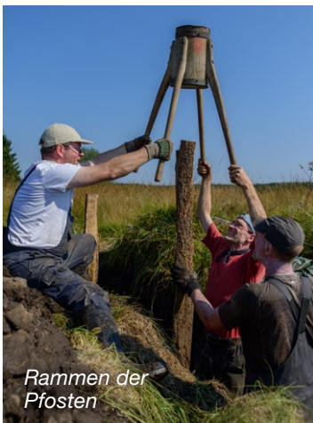
Vorbau einer Bohlenwand
